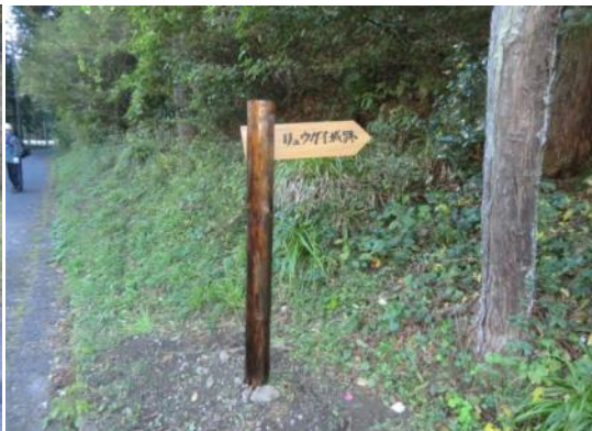
防腐剤を支柱全面に塗付
